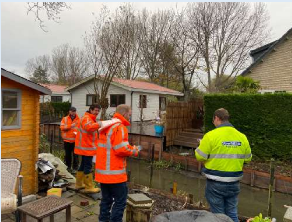
Inventarisatie van werkzaamheden aan beschoeiingen en oevers (foto: Eduard Groen)
